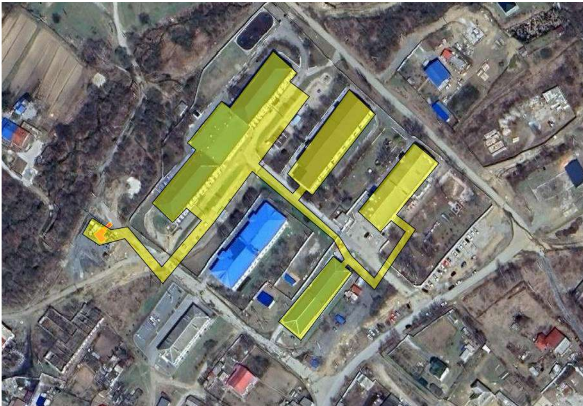
Рис.6 – Зона действия котельной ГВС № АМК 4/14.1, с. Екатериновка ул. Советская, 3А
